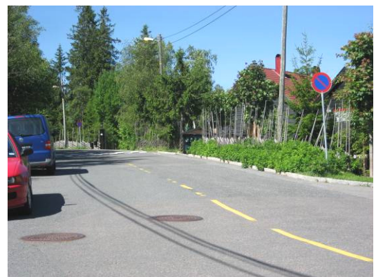
Bilde 20 (høyre): Fartshump er etablert i Voksenkollveien mellom Voksenåsen stasjon og Lysebuveien
