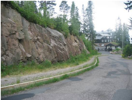
Bilde 10 (venstre): Lillevannsveien, fortau er delvis ferdigstilt
