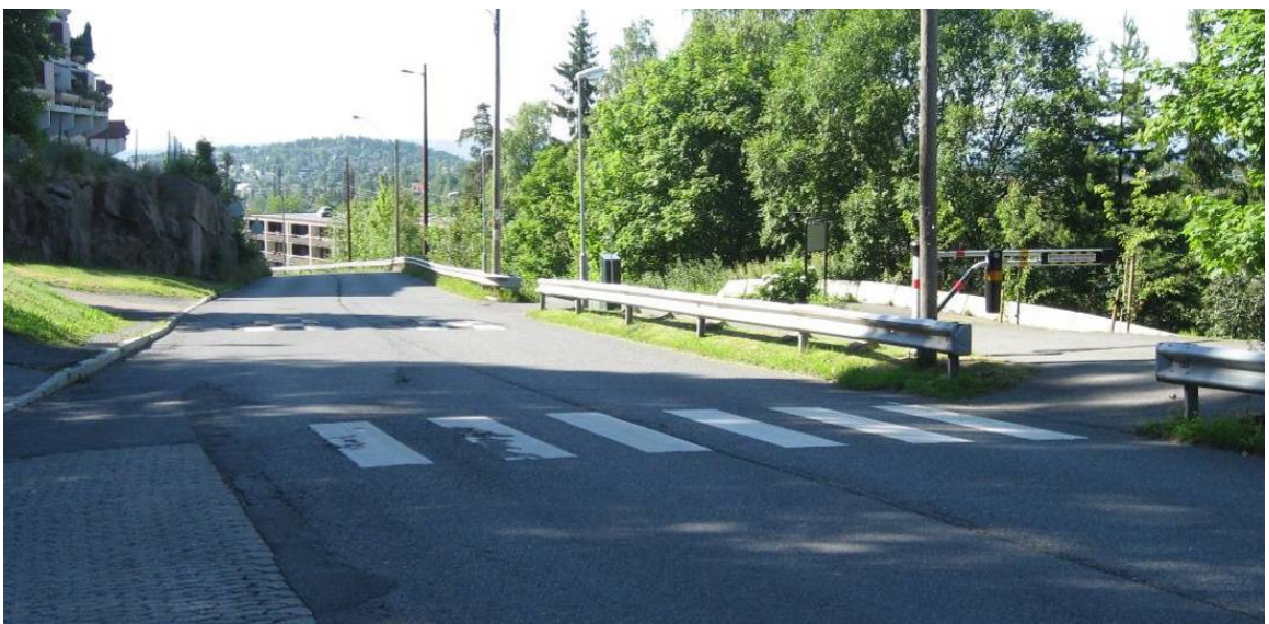
Bilde 26: Gangfelt over Olaf Bulls vei. Fartshumper er etablert nedenfor gangfelt.
